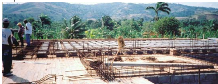
La prima soletta : lato chiesa prima della gettata di cemento
