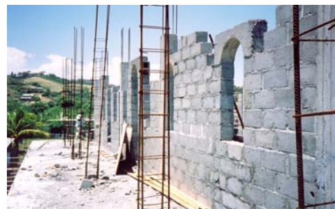
Primo piano : costruzione del muro perimetrale
