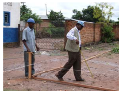
Si comincia con il tracciamento... ecco l'ingegnere al lavoro
